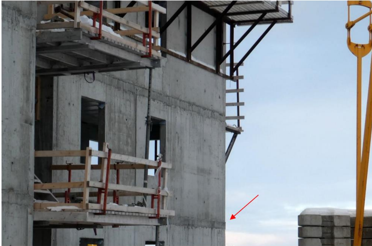
Figur 9. Fotos fra opførelsen. Især omkring etagedækkene ser betonoverfladen ud til at være mere ru end Rockwools (nuværende) forskrifter. På billedet øverst kan man på hjørnet af nederste etageadskillelse (rød pil) se, at ujævnheden må ligge over de maximale 5 mm. På foto herunder ses tilsvarende ujævnheder omkring etagedækket, men også brystningerne ser ud til at være ujævne.
