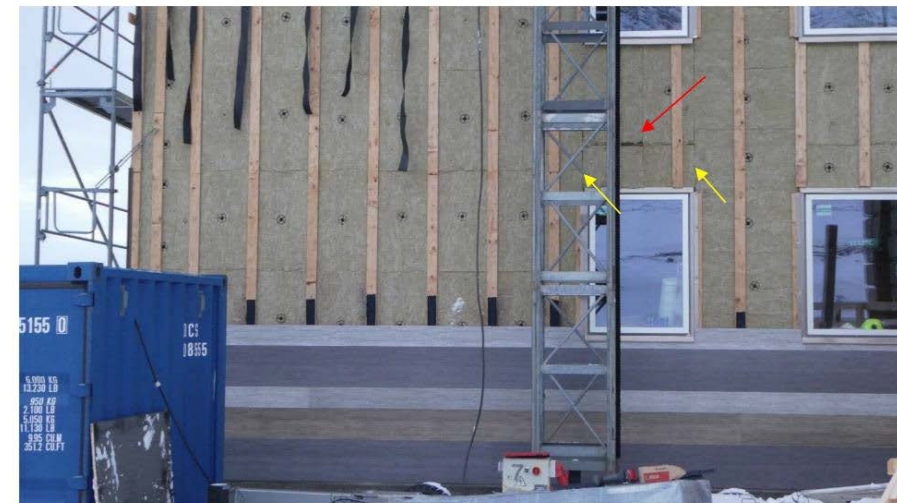
Figur 9. Fotos fra opførelsen. Især omkring etagedækkene ser betonoverfladen ud til at være mere ru end Rockwools (nuværende) forskrifter. På billedet øverst kan man på hjørnet af nederste etageadskillelse (rød pil) se, at ujævnheden må ligge over de maximale 5 mm. På foto herunder ses tilsvarende ujævnheder omkring etagedækket, men også brystningerne ser ud til at være ujævne.
