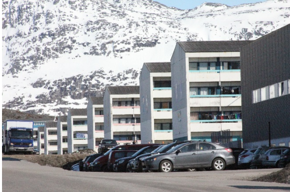
Altangangshuse på Sletten i Nuuk. Tilsvarende boliger findes i mange grønlandske byer.
