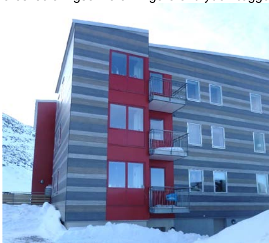
Fig. 6. I hjørnerne af blokkene er der etableret karnapper ved siden af altanerne. I karnapperne er der placeret et let element, bestående af to vinduer og en brystning i en let konstruktion. Elementet er delvist færdigleveret fra fabrik
