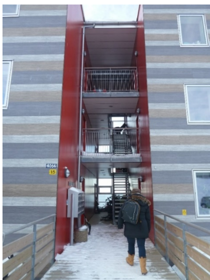
Fig. 25. Trapperum, der ligger mellem blokkens to adskilte bygninger. Der er monteret glasparti til siden mod vandet, men er åben til den anden side. Dette betyder bl.a. at der fyger sne ind i trapperummet.
